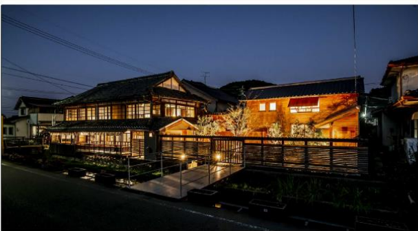
母屋に2部屋、離れに1部屋。建物の歴史から名付けたお部屋「質」「煙」「継」をご用意 たばこ屋のカウンターで使われていたガラス棚はフロントとして 母屋に残る質蔵だった部分は2階へ上がる階段へと続く扉として残しています
