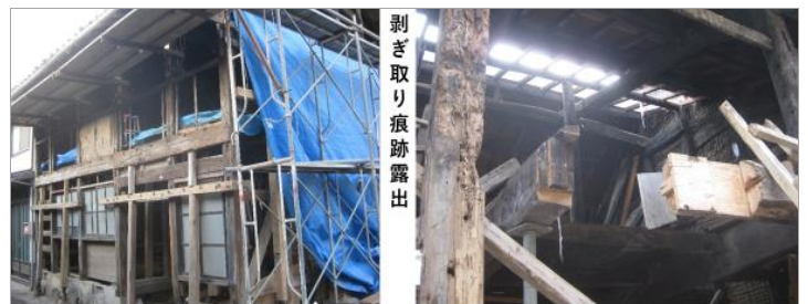
角材突きとベルト引きによるイガミ突き(建起こし) 部材補修
