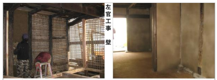
大壁修復 左官工事 壁 通り土間 土壁中塗り仕上げ
