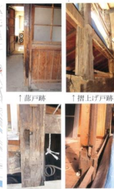
↑方杖・腕木跡(二階) ↑敷居跡(二階)
