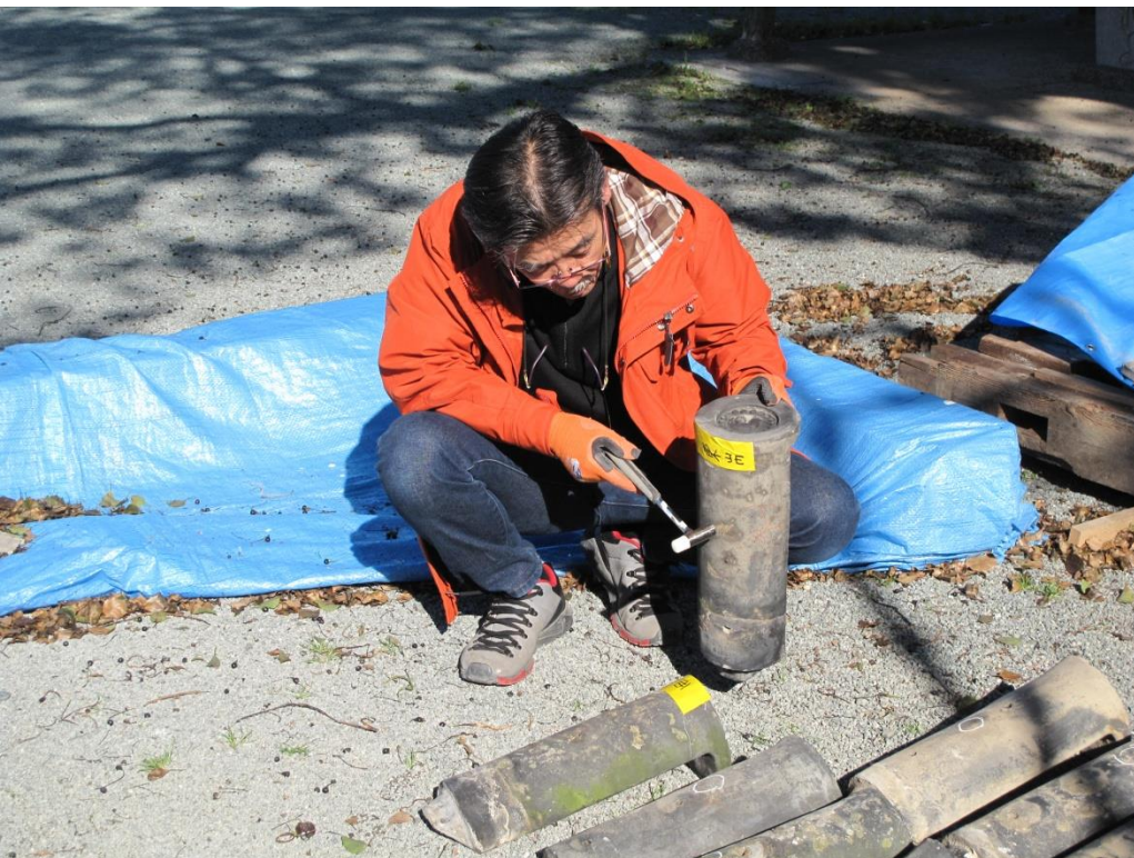
既設瓦を叩いて音で再用できるか調査
