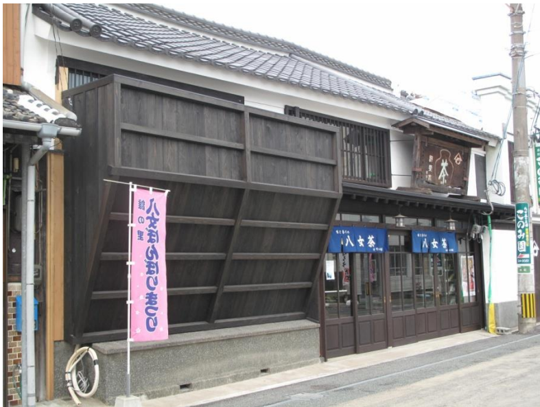
修理後 日除けの復原
