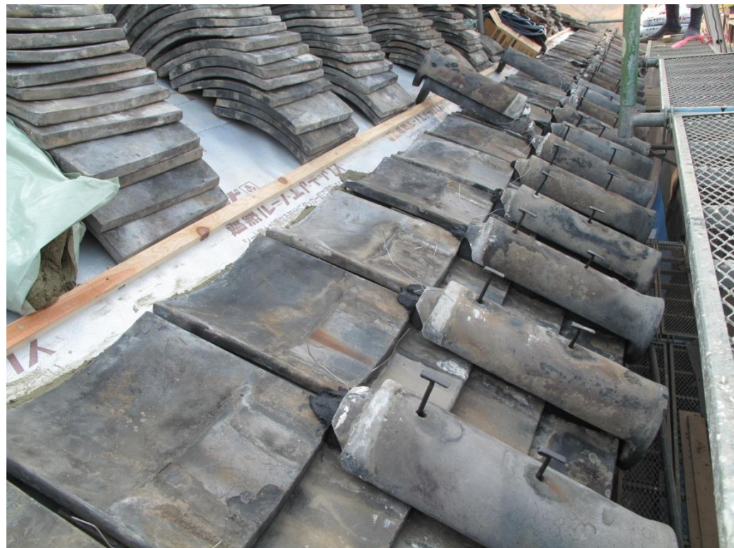
本瓦葺き（古瓦再用） 土で筋葺きをする
