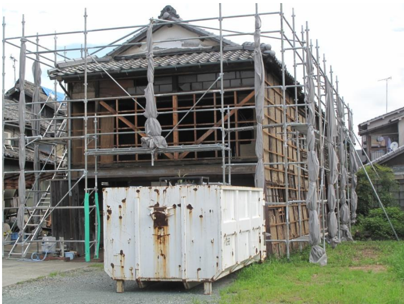
土壁（真壁）を復原できなかった小石原家
