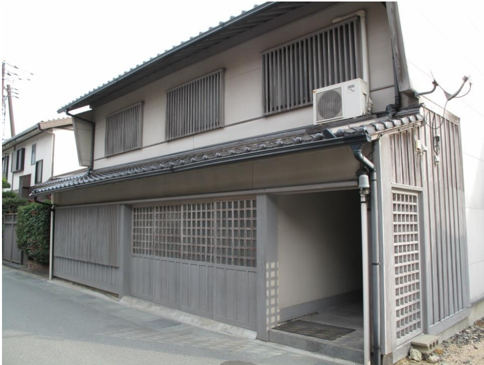
萩市浜伝建地区 新築修景
