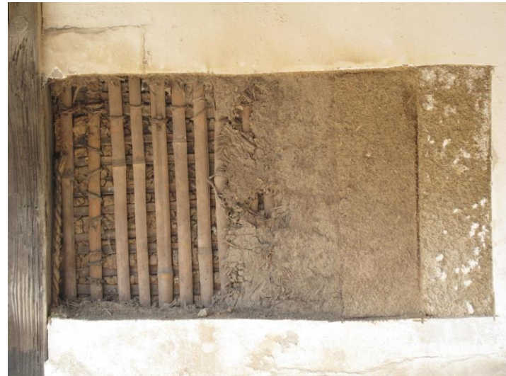
塀の土壁トレンチカット
