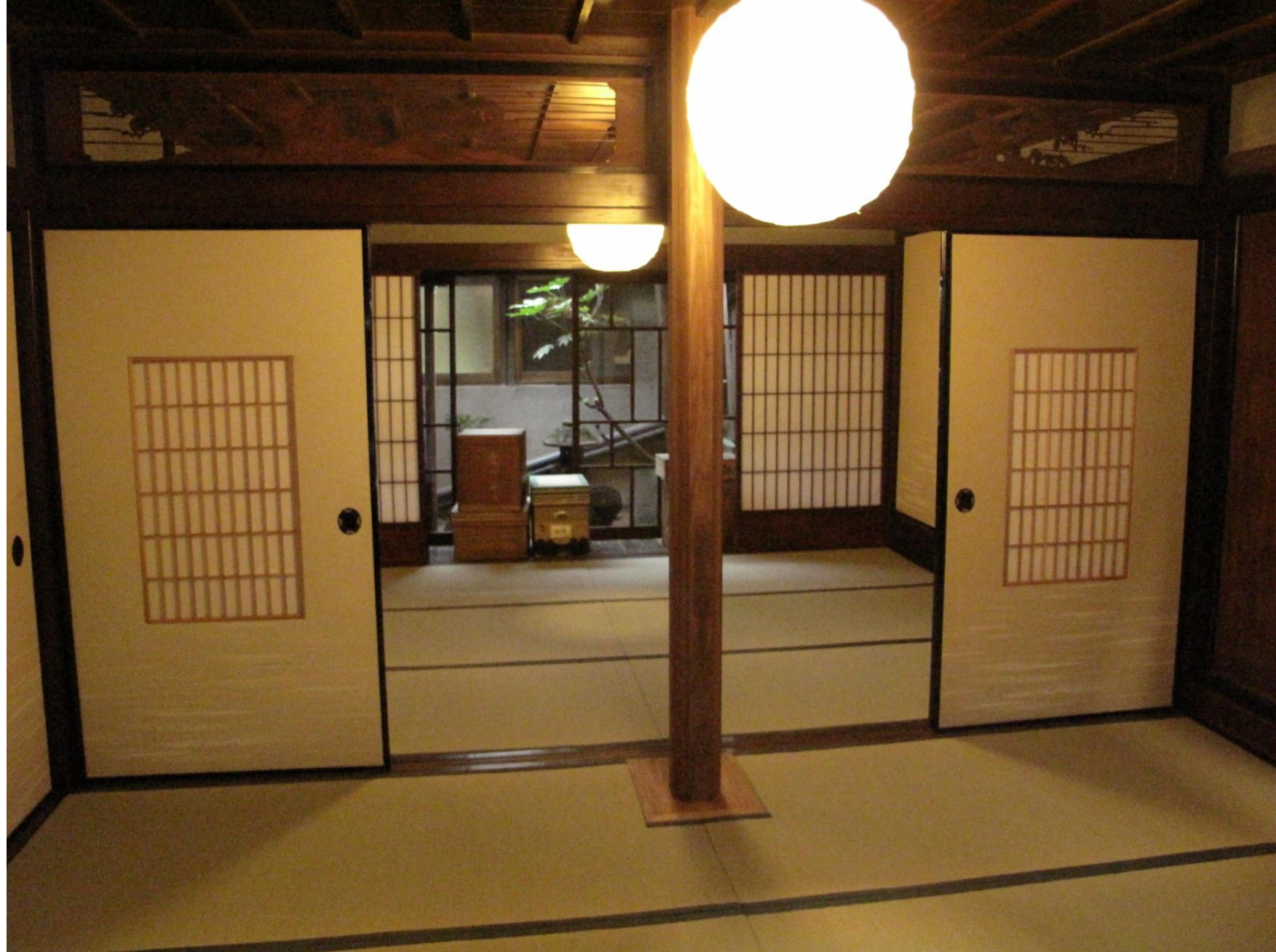
許斐家（このみ園） 離れ座敷 補強柱
