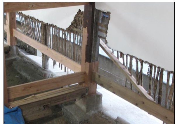
—町家の保存修理:柱根継ぎ—
