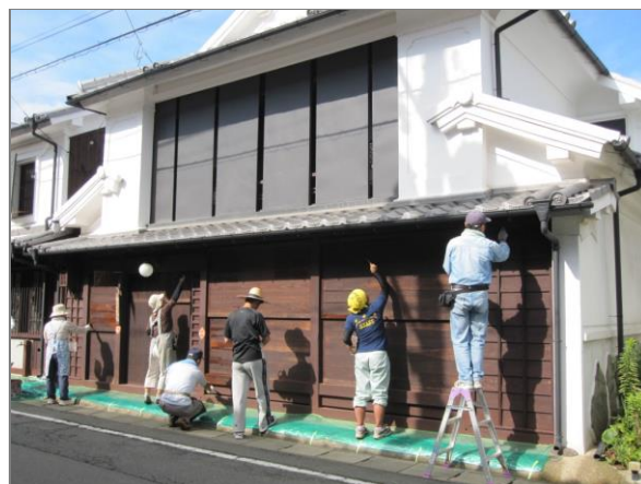
—町家の手入れ:べんがら柿渋塗り—
