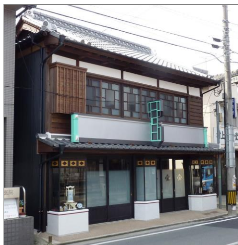
— 町家の修理事業:修理前(上):修理後(下)—
